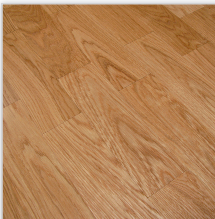
Parkiet dębowy Wymiary (szer./dł./gr.) [mm]: (50, 60, 70, 100, 120, 150)/(1000, 800, 600, 500, 420, 400, 360, 350, 300)/(22, 16). Klasa: I-III.
